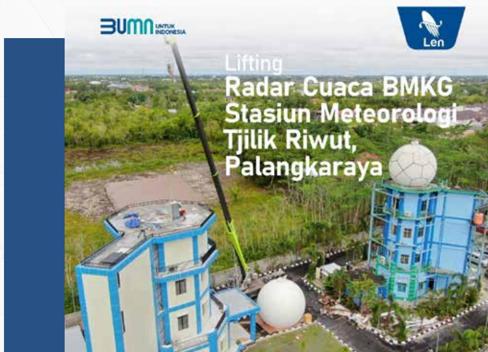
Radar cuaca BMKG di Palangkaraya (Sumber: Akun X PT Len Industri (Persero))
